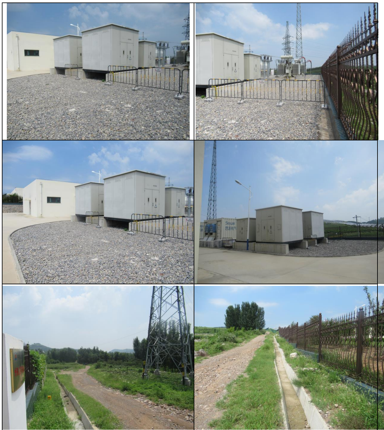
开关站区砾石覆盖及截水沟
