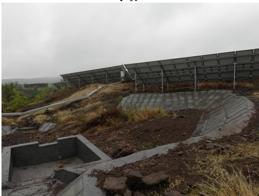
护坡及沉沙池
